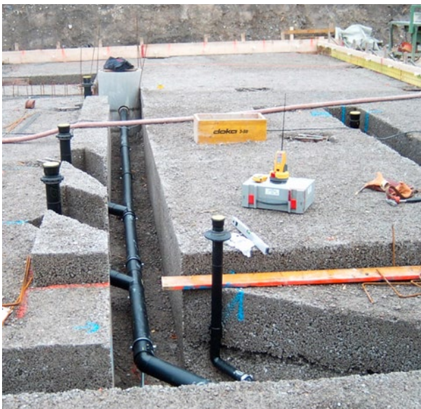
Abb. 12: Je nach Art des Pressrings muss eine regelmässige Wartung durchgeführt werden. Die Zugänglichkeit muss gewährleistet sein.
